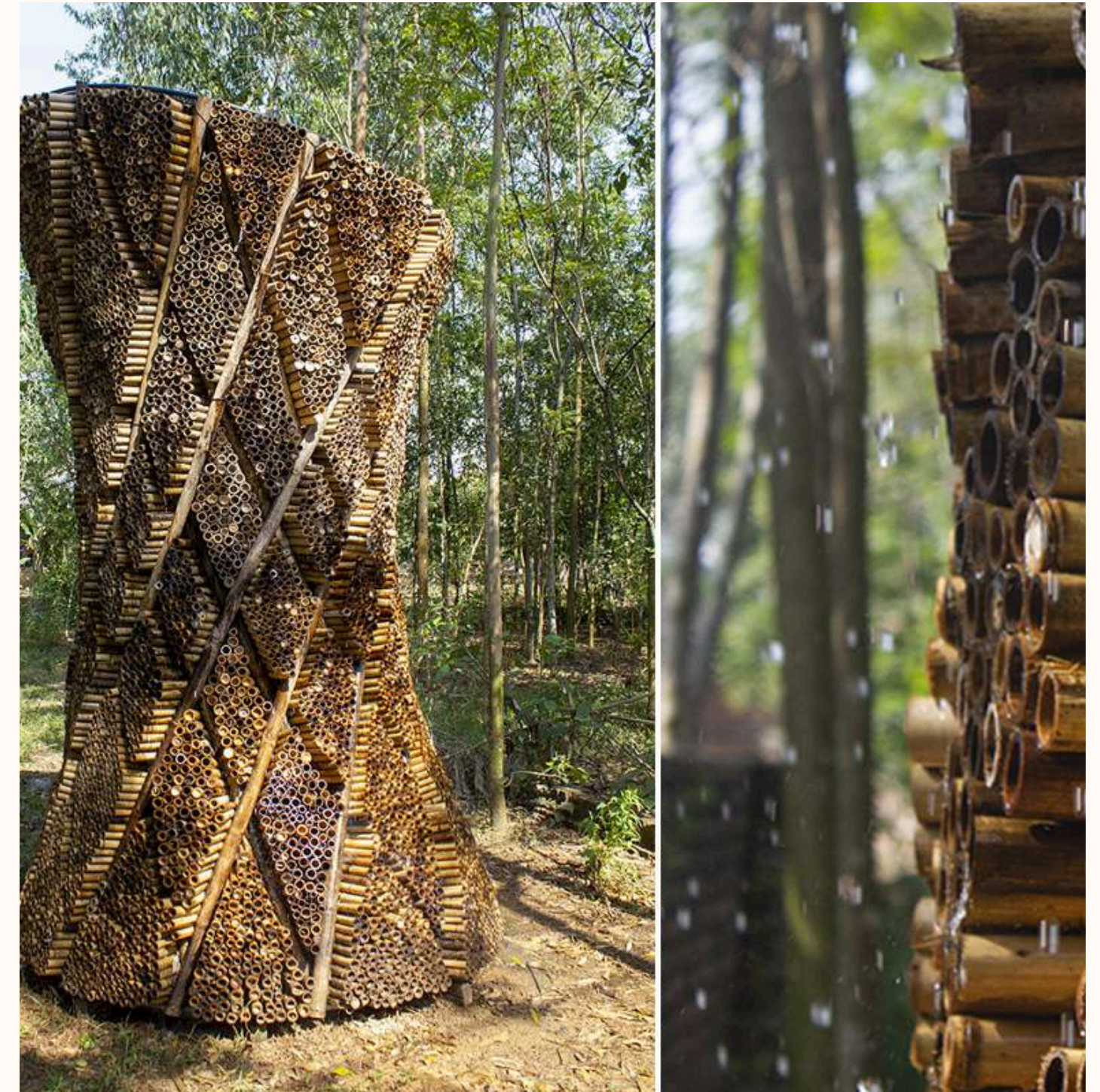
exemple de tour adiabatique en bambou avec ventilation
