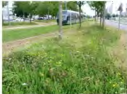
Aménagement et gestion voie verte du tram (quartier du 8 Mai 1945) (SEGED – ALEZIER S.)
