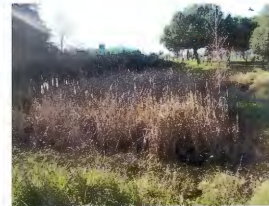
Bassin artificiel d'eau pluviale au nord du Parc Palmer (SEGED – ALEZIER S.)
