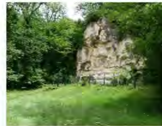
Fissure dans une falaise du Parc Palmer (SEGED – ALEZIER S.)
