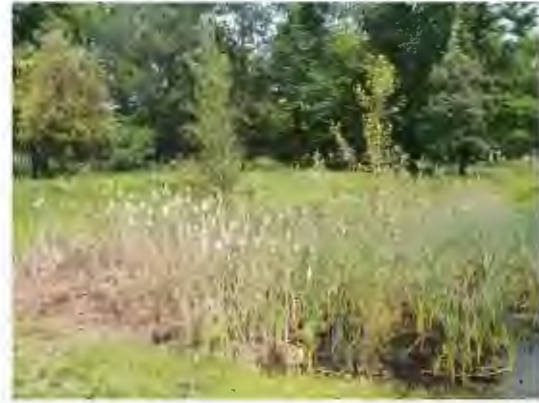
Bassin de récupération d'eau pluviale (Palmer) (SEGED – ALEZIER S.)
