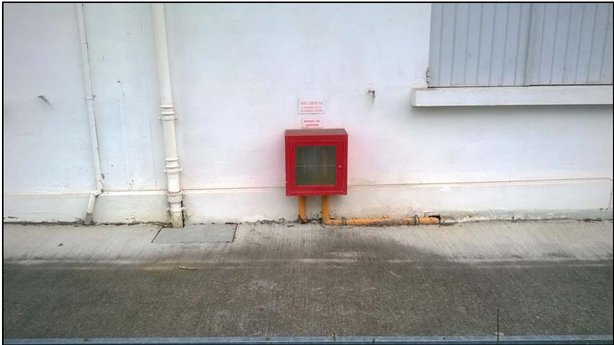
Figure 36 : Vanne de coupure de gaz de l'école de Clairière
