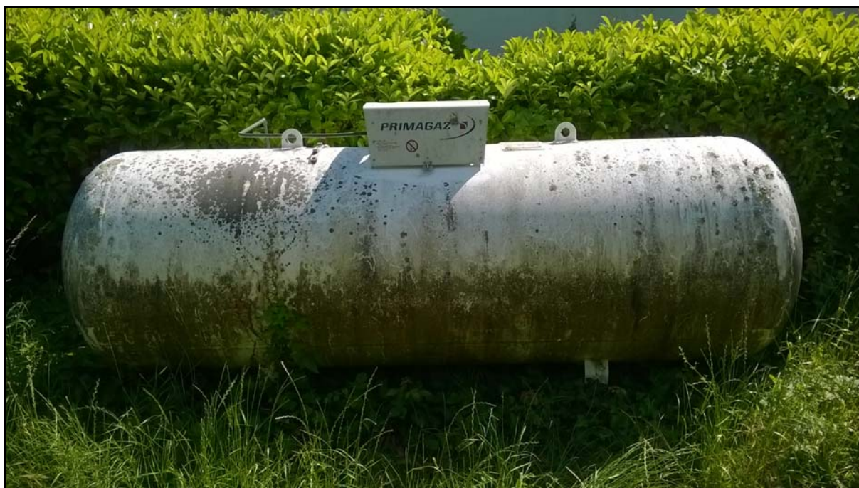
Figure 34 : Cuve aérienne de gaz de 1978 (15.052.RA.001.01.fig34)
