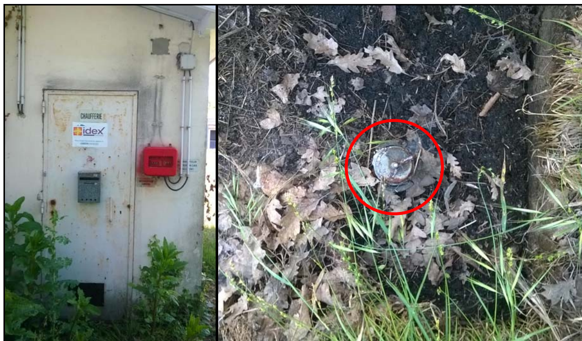
Figure 33 : Local chaufferie et canalisation de remplissage de la cuve de fioul (15.052.RA.001.01.fig33)
