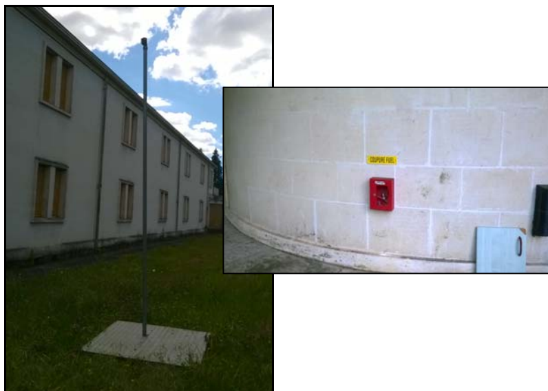
Figure 32 : Event et vanne de coupure de fioul (15.052.RA.001.01.fig32)
