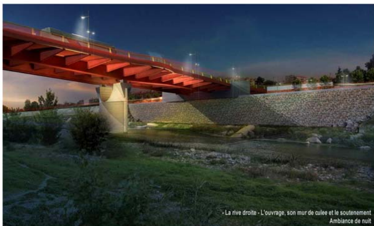
Figure 5 - Pont sur la Têt (Maître d'œuvre ARCADIS)
