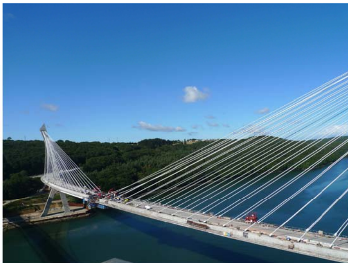
Figure 2 - Pont de Terenez (en cours de construction, études d'exécution ARCADIS)
