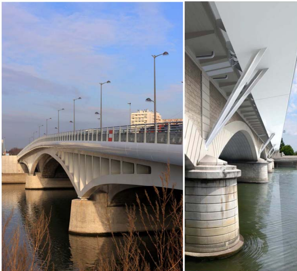
Figure 10 - Passerelles de Bezons (gauche) et passerelle du Pont National (droite) (Maîtrise d'œuvre ARCADIS)
