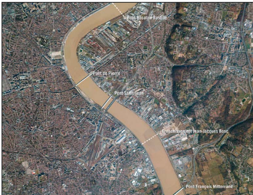
Figure 4 : Localisation Pont Bacalan Bastide/ Futur Franchissement Jean Jacques Bosc
