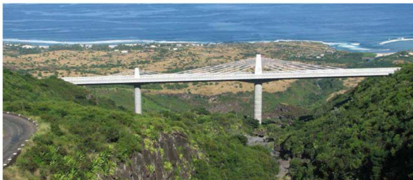
Figure 3 - Pont Ravine des 3 bassins (Maître d'œuvre ARCADIS)
