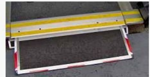
Rampe courte portes 2 et 3
