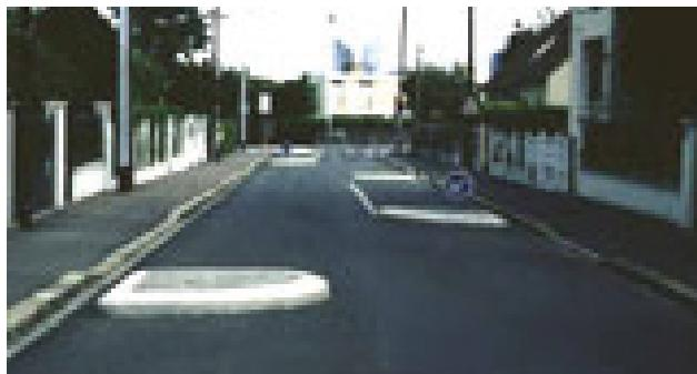
Chicane par déformation volontaire de l'abord de la chaussée
