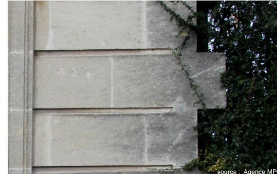
Appareillage de pierre à bossage
