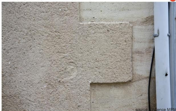
Enduit projeté rustique et taloché fin peint en soubassement
