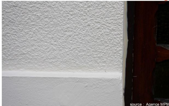
Enduit projeté rustique et taloché fin peint en soubassement
