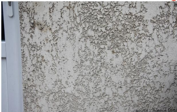
Enduit projeté et gratté en surépaisseur
