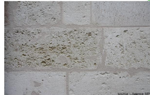
Enduit à la chaux à pierre vue
