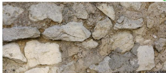
Appareillage de pierre avec joint creux - façon bossage
