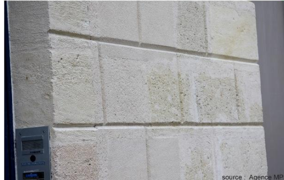
Appareillage de pierre avec joint creux - façon bossage
