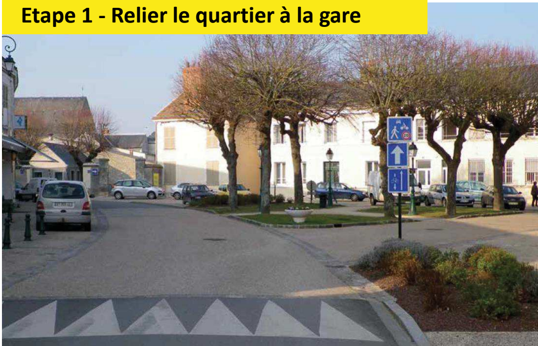
Exemple de passage piéton surélevé, possible pour la traversée devant la gare
