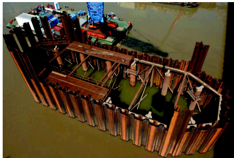
Photographie 5 : batardeau provisoire, Egis, Nouveau Pont ferroviaire de Bordeaux
