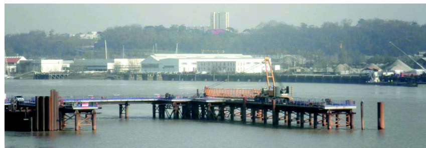
Photographie 6 : exemple d'ouvrages provisoires en rivière, Egis, Pont Jacques Chaban Delmas à Bordeaux
