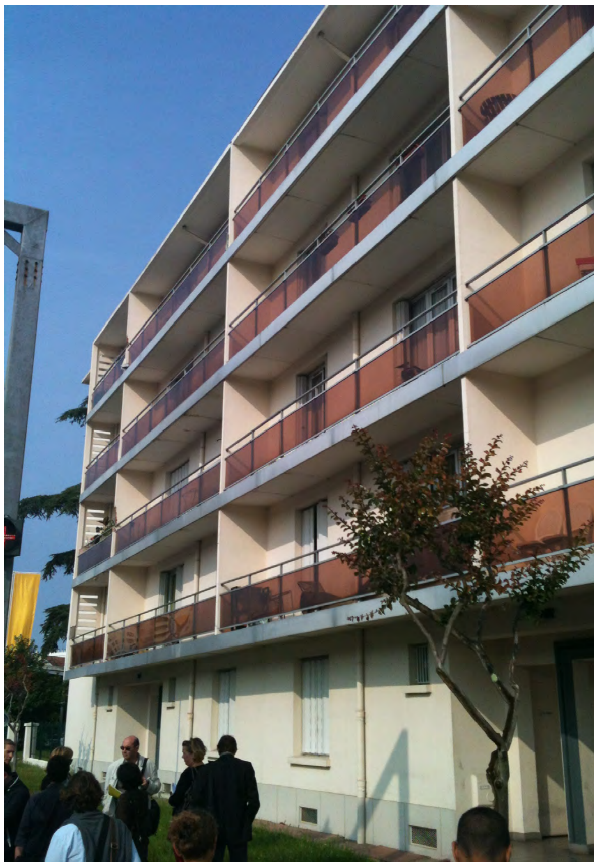
PROJET DE DENSIFICATION DE LA RESIDENCE JEAN MOULIN GIRONDE HABITAT - RCR ARTOTEC 27 MAI 2014 PHOTO A HAUTEUR DU PIETON DE L'EXISTANT
