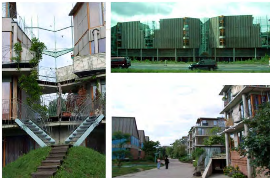
Projet Nutheschlange (Potsdam – Allemagne) avec un agencement de bâtiment créant un écran antibruit à quelques mètres seulement d'une autoroute.
