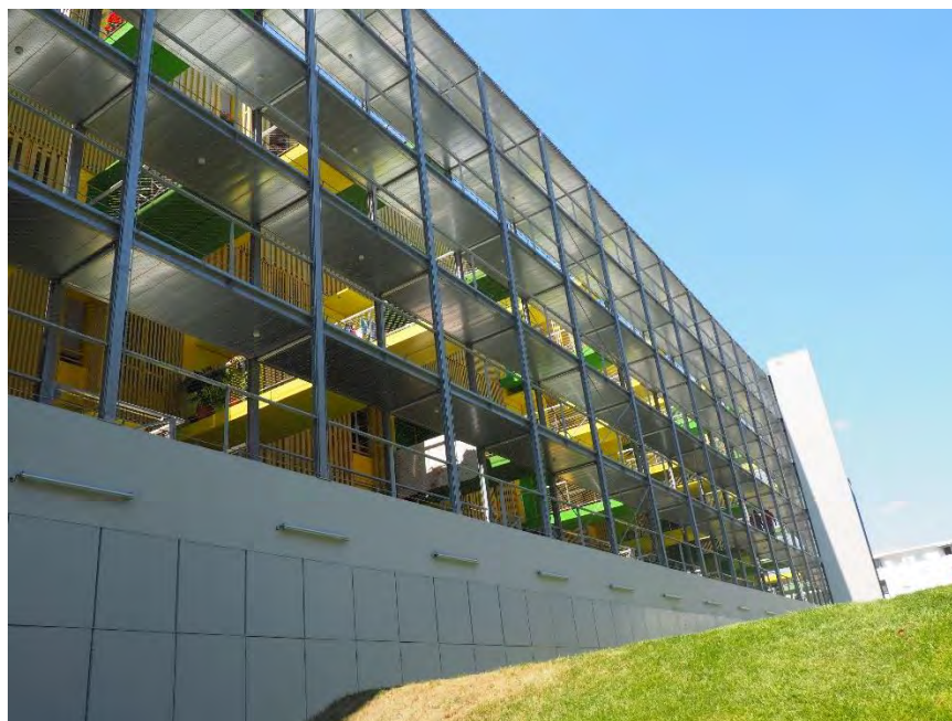
Schéma et exemple de balcons et de coursives permettant de diminuer l'impact du bruit
