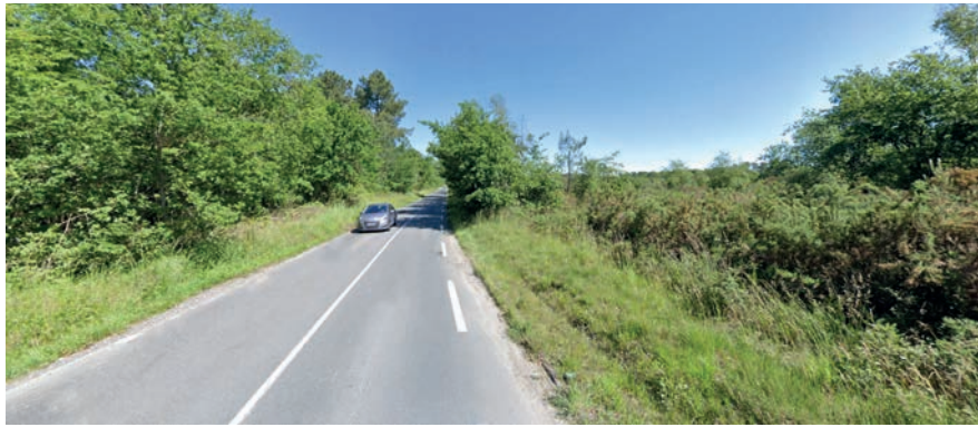
Av. de Pagnot Sud (état des lieux)
