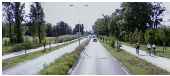
Illustration 26 - Aires piétonnes Avenue François Mitterrand
