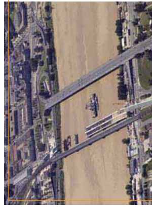
1860 - Passerelle Ferroviaire / 1965 - Pont Saint-Jean 2008 - Nouveau Pont Ferroviaire
