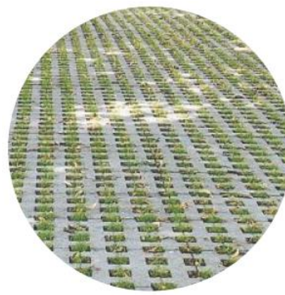
Exemples d'aménagements de stationnements (gauche et milieu) / dalles evergreen à droite
