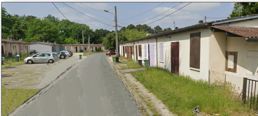
Vue des lieux à déclasser comprenant le trottoir de droite, tout au long de ce bâtiment
