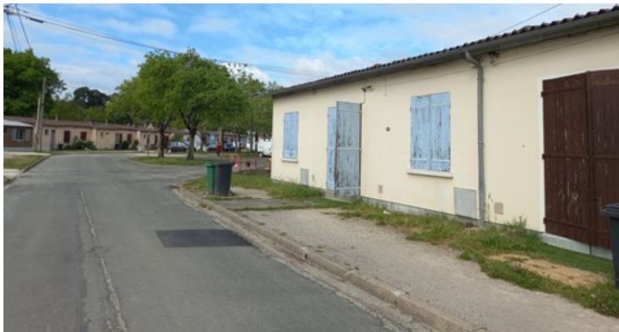
La parcelle à déclasser correspond au trottoir situé devant l'immeuble sur toute sa longueur
