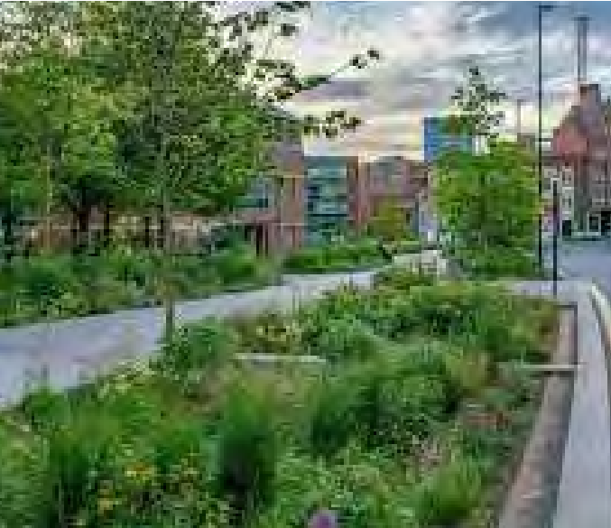
Dépollution - tranchée drainante - infiltration
