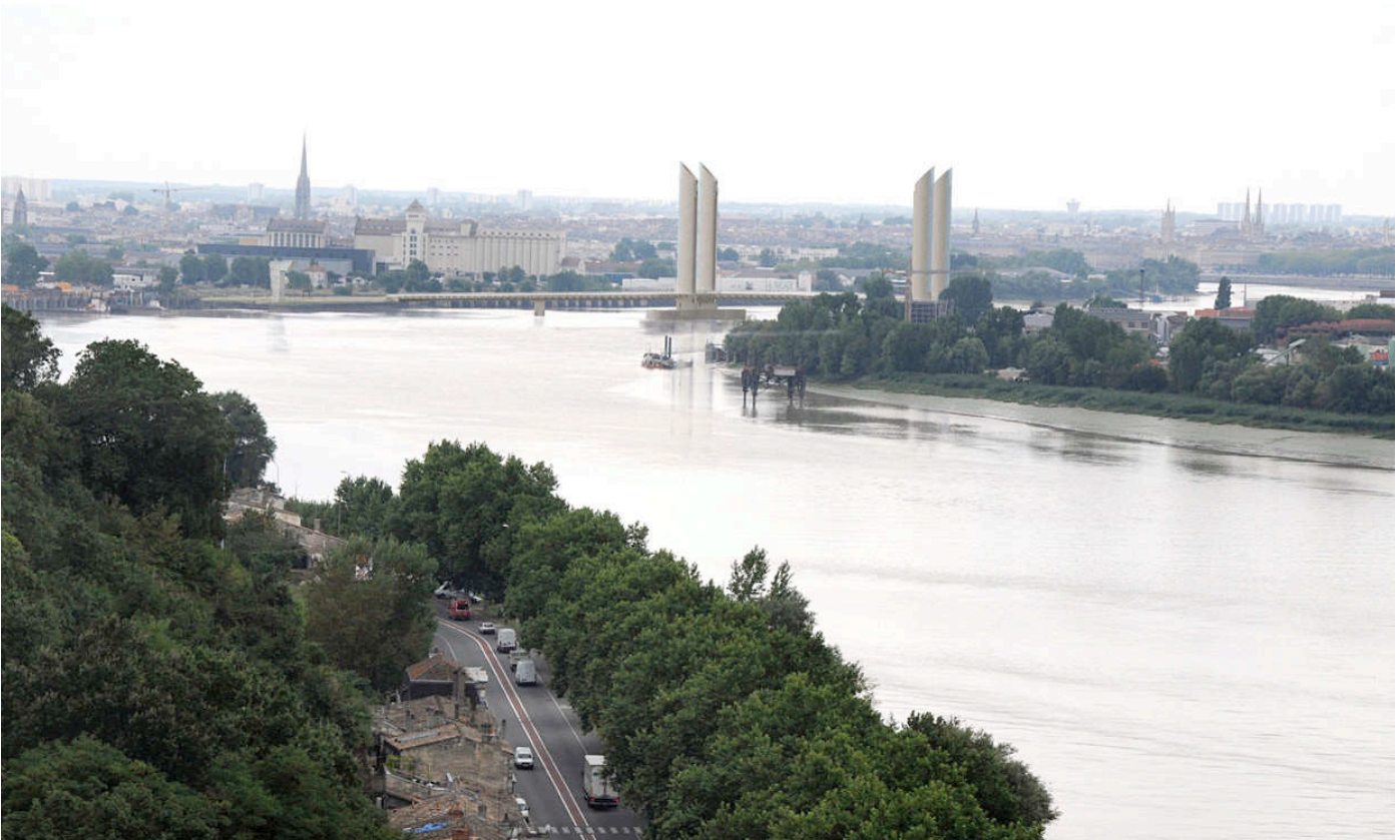
Le pont Bacalan-Bastide vu depuis Lormont.
