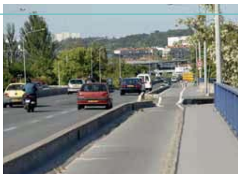
Séparateurs réduits entre voies et pistes cyclables, sentiment d'insécurité. La vitesse des véhicules rend d'autant plus inconfortable la pratique du vélo sur l'ouvrage.
