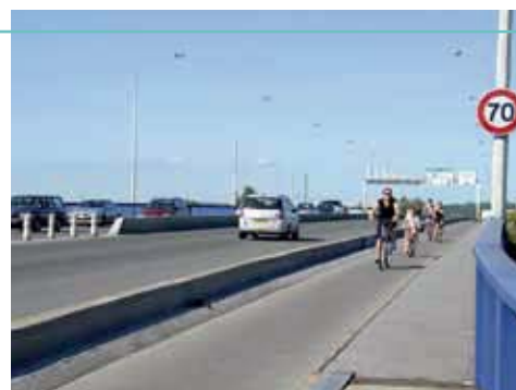
Séparateurs réduits entre voies et pistes cyclables, sentiment d'insécurité. La vitesse des véhicules rend d'autant plus inconfortable la pratique du vélo sur l'ouvrage.
