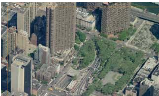
Sortie ouest du tunnel.
