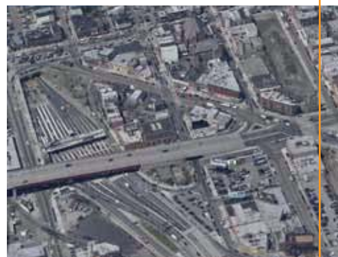
Sortie est du tunnel.
