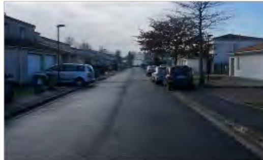
Stationnements sur les trottoirs et espaces verts
