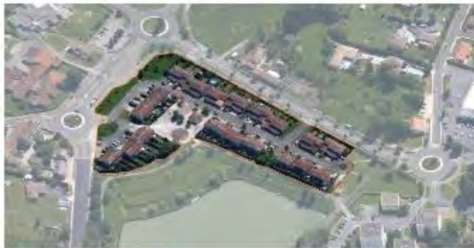
Vue depuis le Nord
