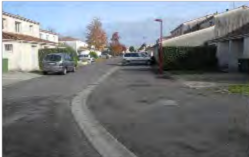
Gabarit de voirie surdimensionné
