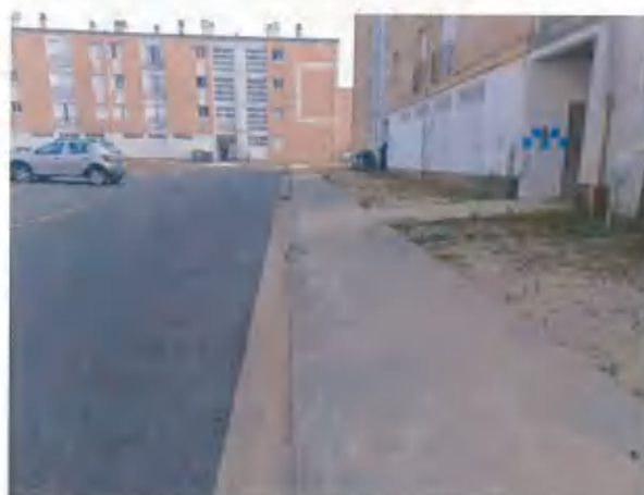
Emprise à déclasser vue rive est face au bâtiment 43-42
