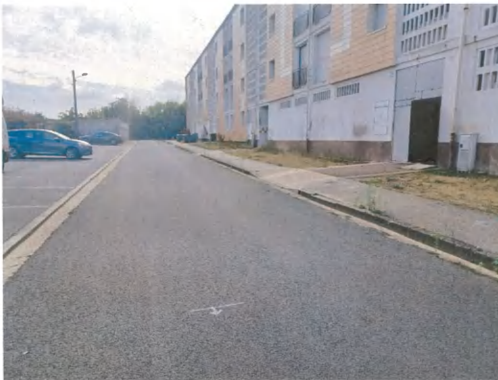
Vue face au bâtiment n° 38 à 41 (DVL face aux entrées bâtiments)
