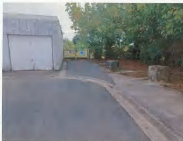
Emprise à déclasser vue accès riverain dans l'angle
