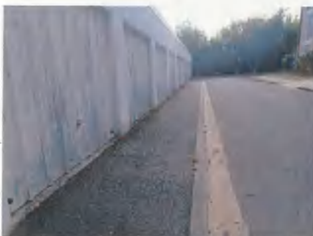
Emprise à déclasser vue garages privatifs rive nord
