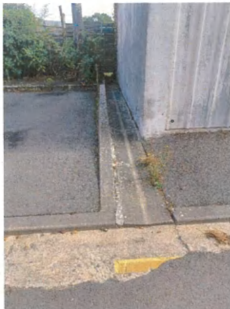
Ouvrage assainissement rive Nord angle garage privatif
