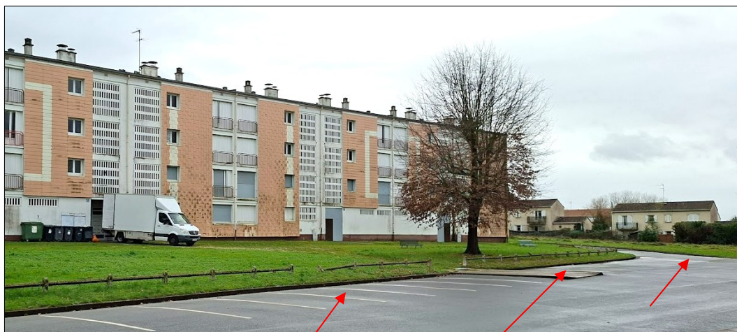
Vue d'une partie du parking et de la rue à déclasser avenue Bel Air (photo CE)
