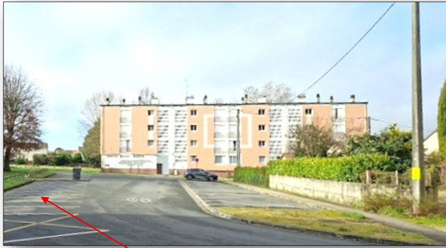
Vue d'une partie de la voie à déclasser sur le côté gauche (photo C.E)
