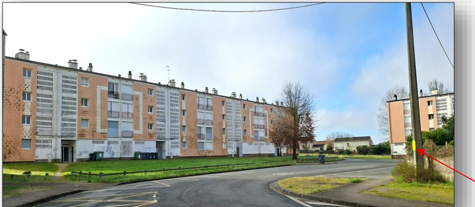
Une partie des espaces à déclasser sur la gauche. On remarque l'affichage
