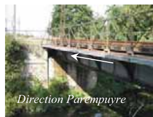
OA8 existant – PRA de la Jalle de Blanquefort
