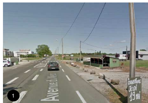
1 Poteaux électriques, téléphoniques et candélabres jallonnent l'avenue du Médoc
