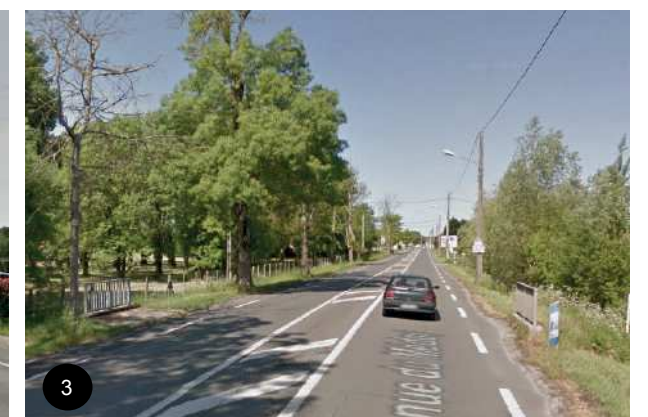
3 Un petit pont permet le passage de l'avenue au dessus du ruisseau
