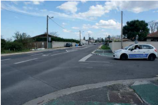
Des traversées dangereuses
