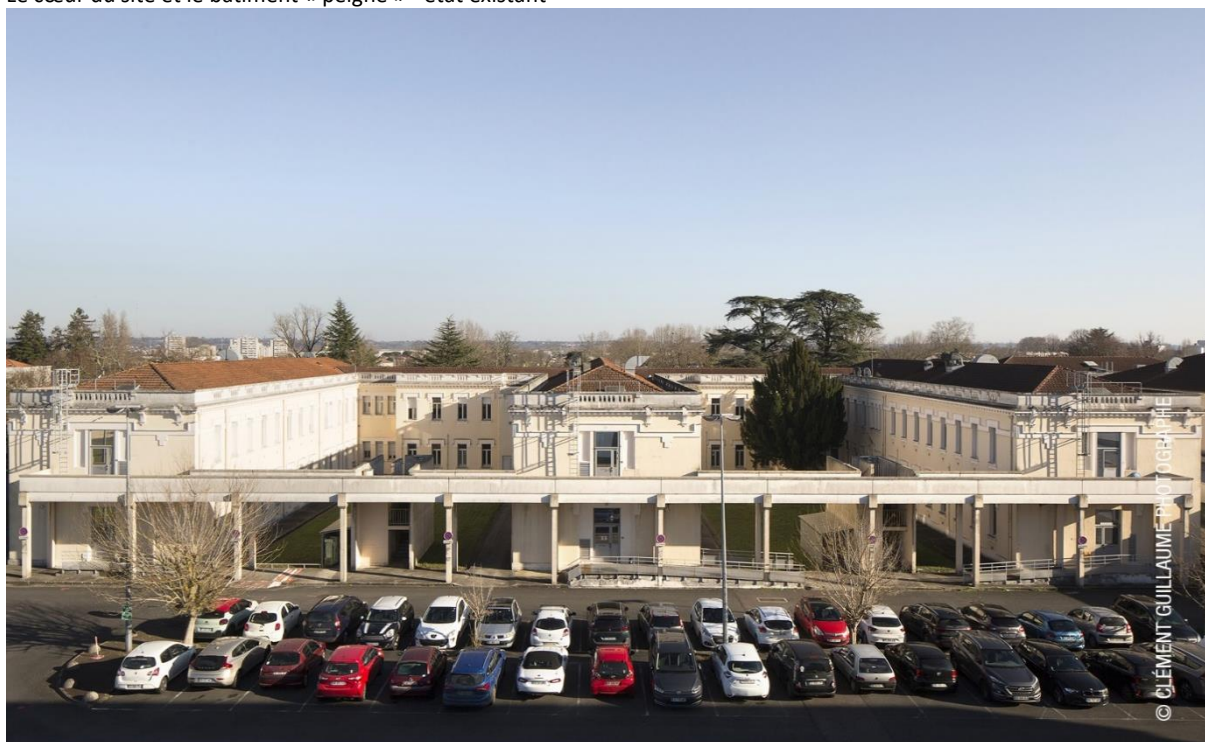
Le cœur du site et le bâtiment « peigne » - état existant
