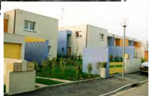
Les maisons du bailleur Aquitanis, à l'entrée de la rue Yves Montand, en construction et après livraison (archives municipales)
