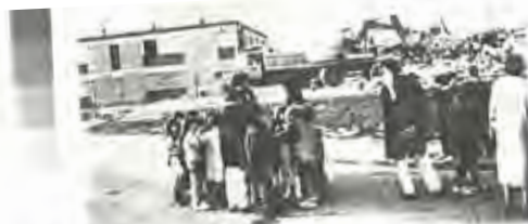
A l'occasion de la démolition des bâtiments Fel G, une visite du chantier par les enfants de l'école du quartier a été organisée avec les enseignants et les membres de l'antenne sociale.
