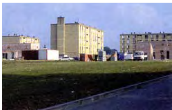
La cité du Moura avant la réhabilitation (archives société l'Habitation Économique)
