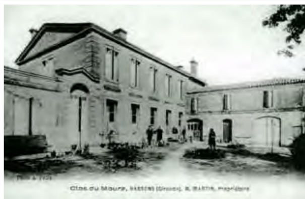
Le clos du Moura, propriété du général Cautanceau, toujours situé à l'angle des rues du Moura et du Lavoir (archives association Histoire et Patrimoine)
