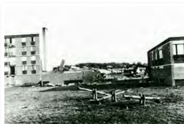
Démolition des bâtiments en vue de la réhabilitation du quartier (archives association Histoire et Patrimoine)
