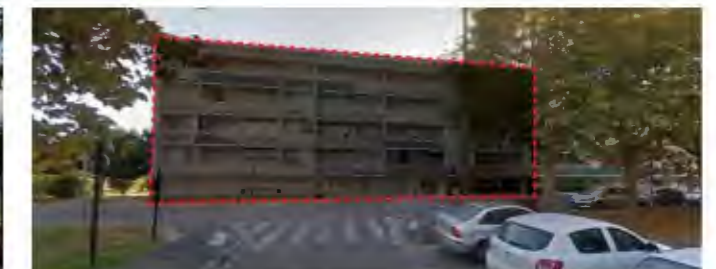
Vue du bâtiment démolí Rue Louis Pergaud (cliché : Devillers & Associés)
