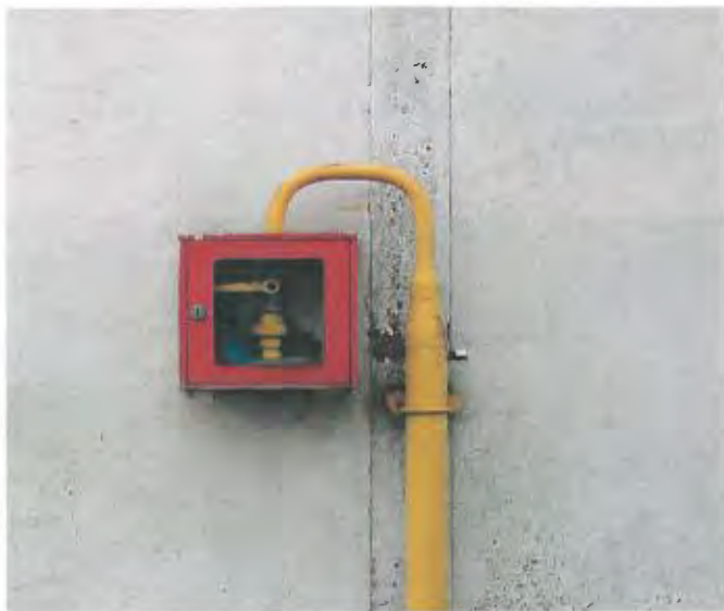
Vanne d'arrivée de gaz fermée
