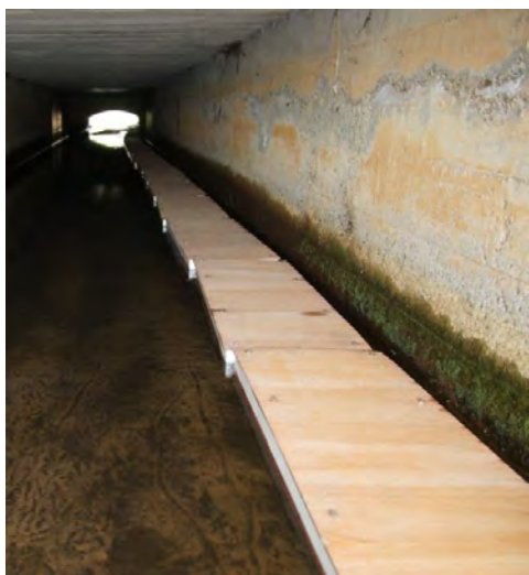
Figure 13 : Exemple de ponton flottant (éléments de 120x40x6 cm : contreplaqué marine de 9 mm, prenant en sandwich une mousse en polyéthylène expansé.) – source GREGE – et exemple de palissade (CD 33) (hauteur 0.80 m à 1 m)
