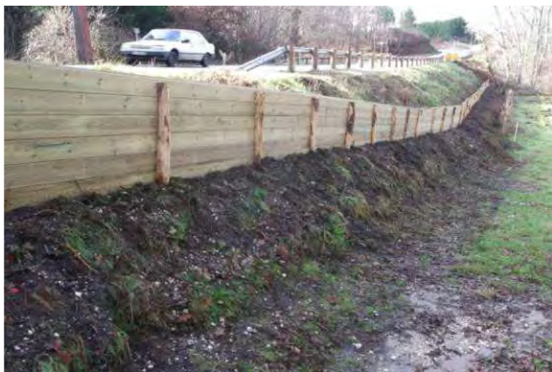
Figure 13 : Exemple de ponton flottant (éléments de 120x40x6 cm : contreplaqué marine de 9 mm, prenant en sandwich une mousse en polyéthylène expansé.) – source GREGE – et exemple de palissade (CD 33) (hauteur 0.80 m à 1 m)
