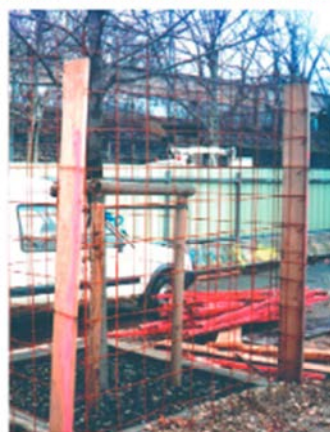
Enceinte de protection avec barrières hautes, ou basses type chantiers propres.
