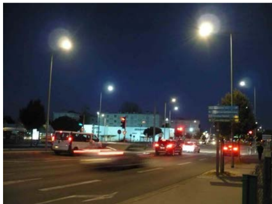
Eclairage à l'intersection des Avenues de Belfort et de la Somme (erea-conseil, 2015)
