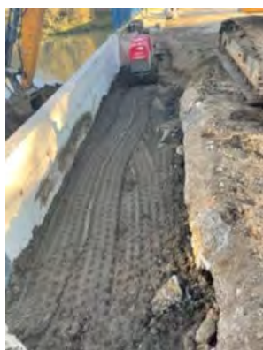
Etape 4 – Etanchéification par un remblai argileux de part et d'autre du muret, pour empêcher l'eau de remonter par en dessous.
