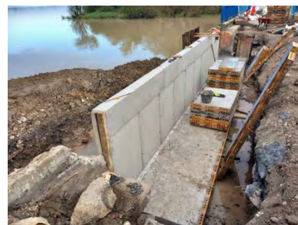
Etape 3 – Bétonnage de la semelle et du voile.
