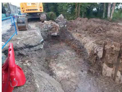
Etape 1 – Démolition du mur existant et terrassement du fond de fouille.
