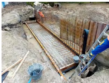
Etape 2 – Pose du ferrailage préfabriqué en usine et coffrage de la semelle (partie inférieure horizontale) et du voile (partie supérieure verticale).
