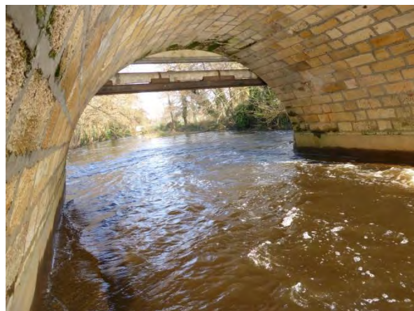
Hautes eaux – chute en aval du pont routier noyée
