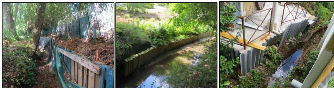
Fig. 28. Exemple de protections de berges : Grandes Badines et Hestigeac
