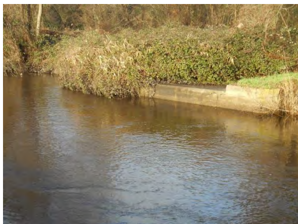
Déversoir vers le canal de décharge
