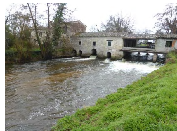
Hautes eaux – vue depuis l'aval
