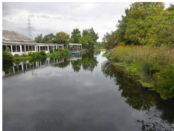
Basses eaux – tronçon amont de la jalle
