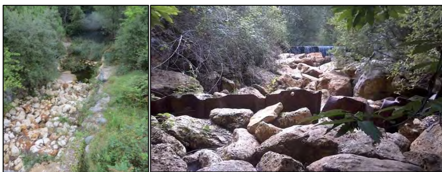
Fig. 38. Aval immédiat du pont St-Hubert – double seuil aval pont St-Hubert : berle de Captieux
