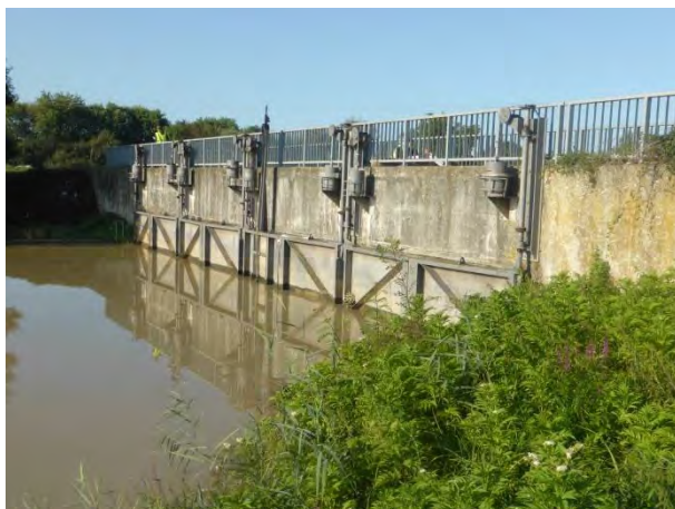
Vue depuis l'aval
