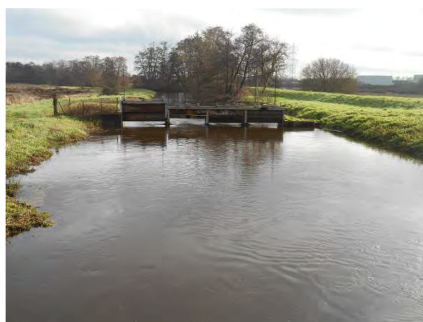
Vue depuis le pont amont (24/01/18)
