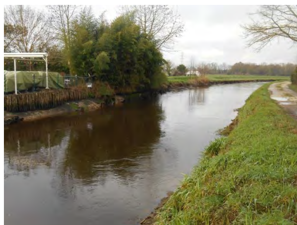
Vue du tronçon amont (24/01/18)
