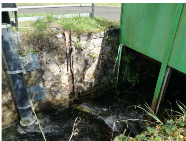
Basses eaux – vannes du bras nord
