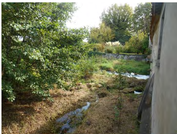
Exutoire du canal de décharge
