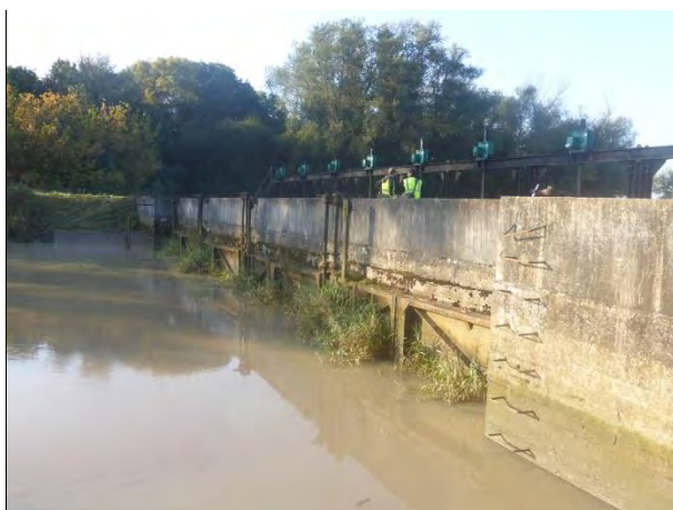
Vue depuis l'aval
