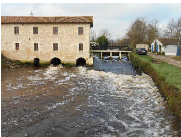
Vue depuis l'aval (24/01/18)
