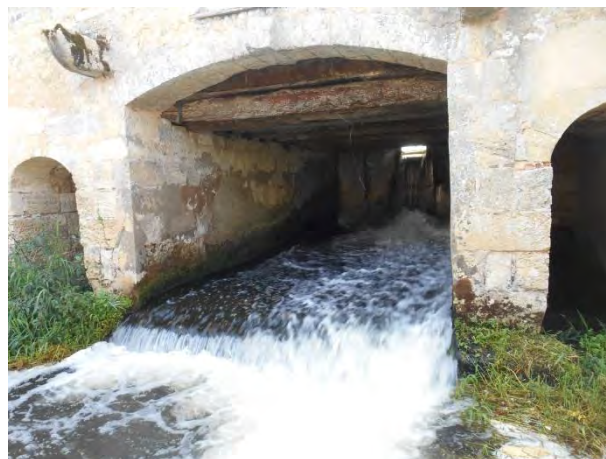
Radier en pente + chute aval
