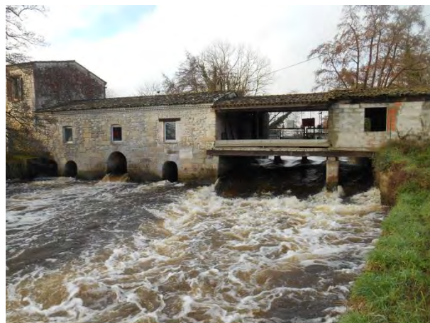
Vue depuis l'aval (24/01/18)
