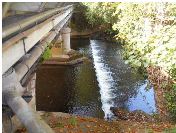
Chute en aval du pont routier
