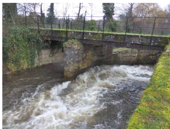
Hautes eaux – écoulement dans l'ouvrage
