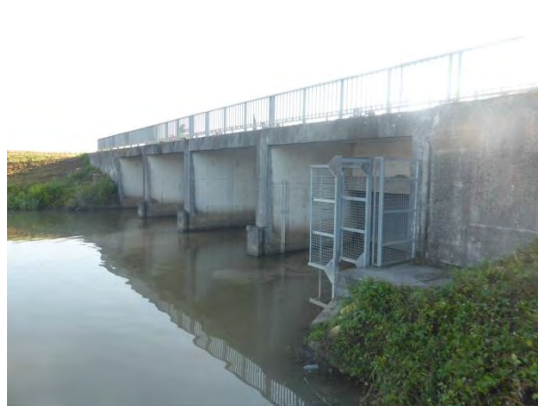
Vue depuis l'amont
