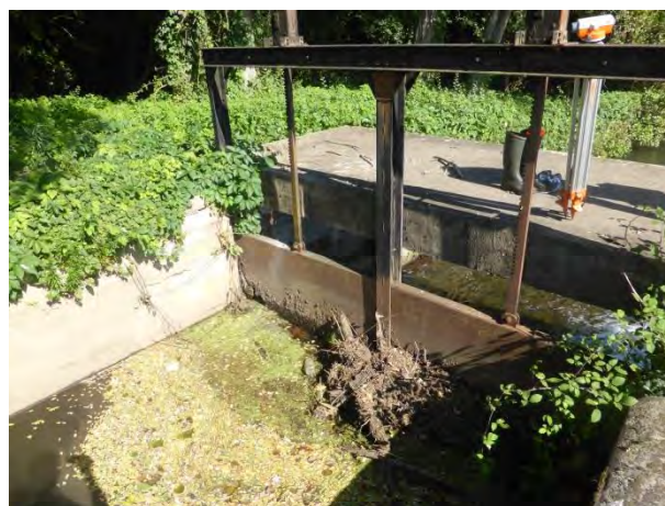
Basses eaux – vue amont
