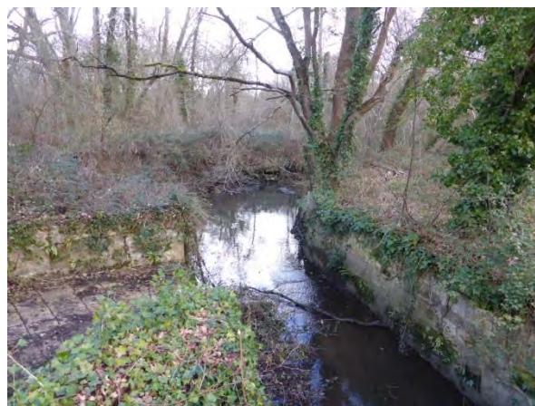
Hautes eaux – canal de décharge
