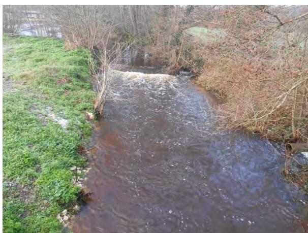
Seuil de la jalle du Taillan (24/01/18)
