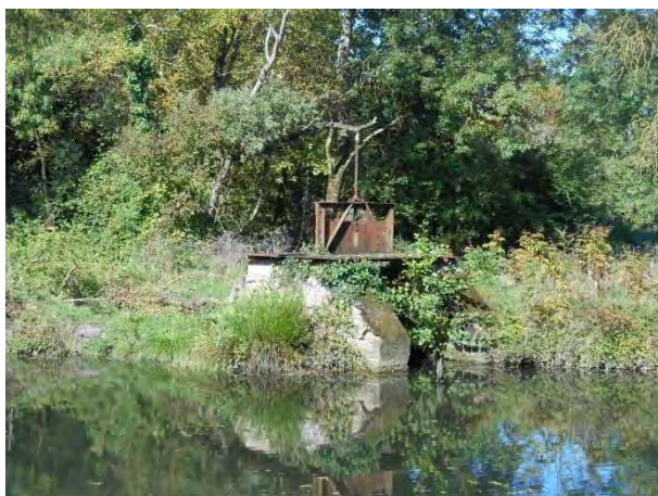
Ouvrage de rejet du fossé RG
