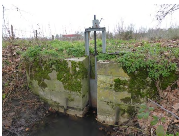
Prise d'eau vers la Réserve Naturelle
