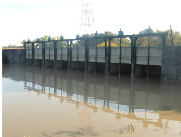
Vue depuis l'amont
