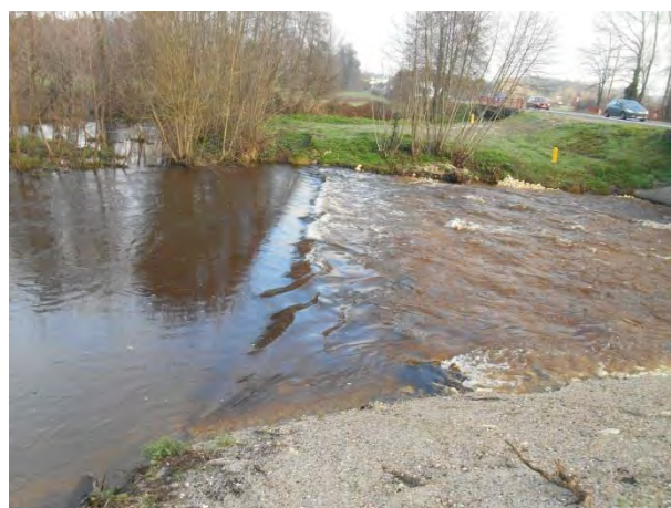
Vue depuis la rive droite après travaux (24/01/18)
