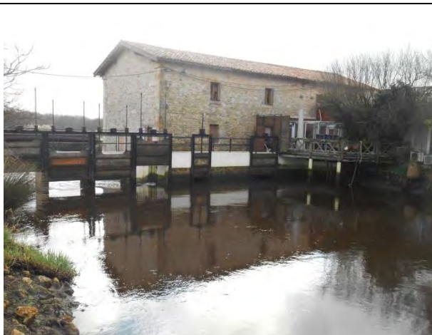
Vue depuis l'amont (24/01/18)
