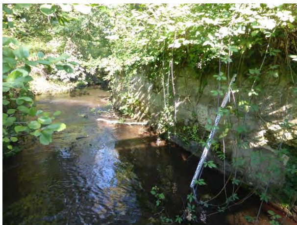
Radier en pente dans le canal de décharge
