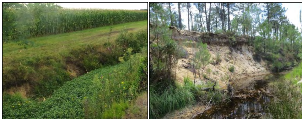
Fig. 48. Erosion : craste Laperge et canal du Joure
