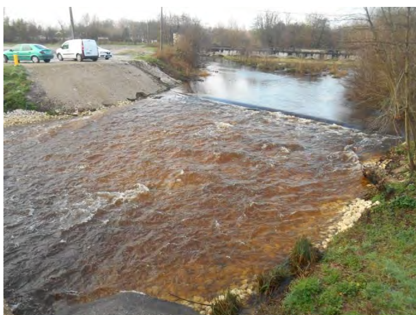
Vue aval après travaux (24/01/18)
