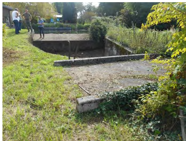
Basses eaux – déversoir du canal de décharge
