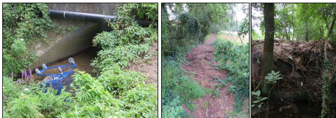
Fig. 27. Dépôt d'ordures : ruisseau du Haillan et déchets verts dans le lit du Monastère et sur les berges du Cerne
