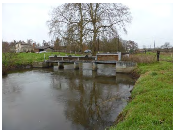
Hautes eaux – vue depuis l'aval
