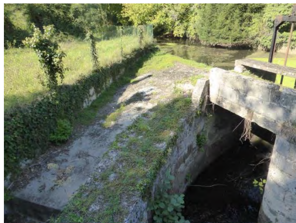
Déversoir et vannes de décharge
