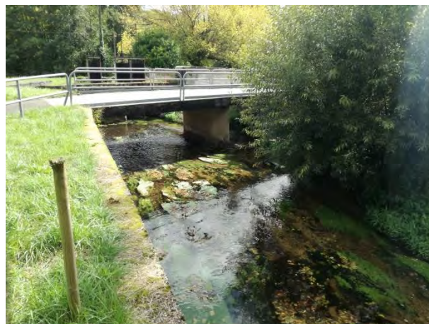
Basses eaux – bras sud amont
