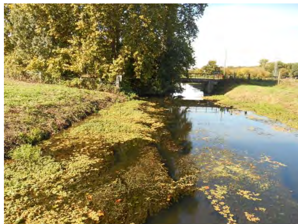
Basses eaux – tronçon amont
