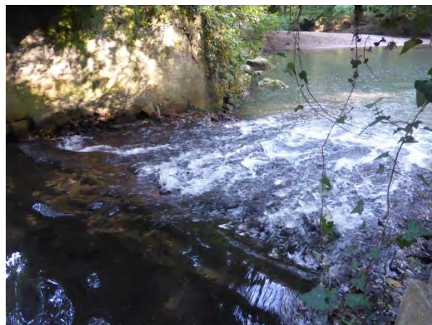
Basses eaux – radier en pente et chute aval
