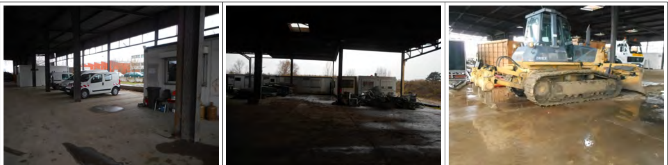
Sous le bâtiment : véhicules légers et de chantier, stockages divers
