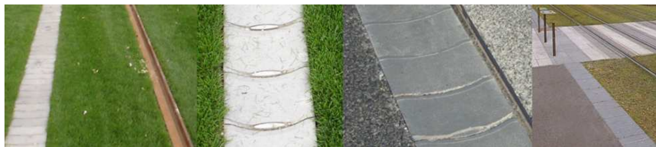
>Déclinaison physique de la limite du « GLO » à travers les différents matériaux utilisés depuis la phase une du projet tramway, de la fonte d'aluminium aux éléments en béton préfabriqués
