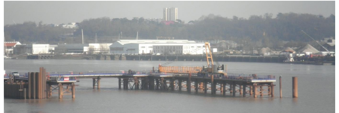
Exemple d'ouvrages provisoires en rivière, Egis, Pont Jacques Chaban Delmas à Bordeaux
