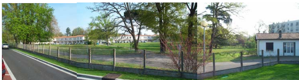
Vue depuis l'avenue Lestage
