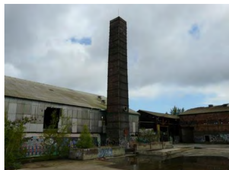
Figure 130 : Photographie de la cheminée de la Cornubia (source : PLU 3.1 de Bordeaux Métropole)
