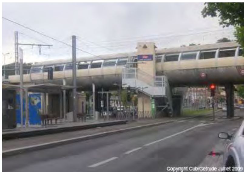
Figure 152 : Pôle multimodal de Cenon Pont Rouge (source Bordeaux Métropole.fr)
