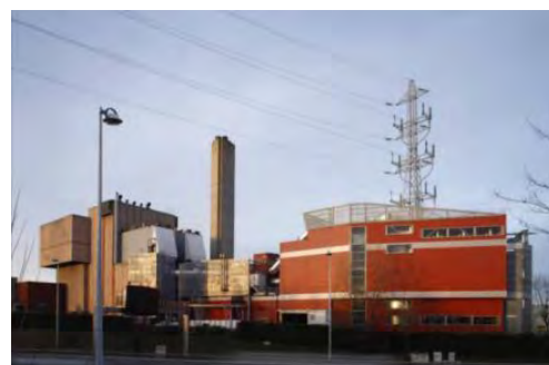
Photographie 14 : Usine 1 du complexe thermique Hauts de Garonne (source : www.rivedroiteenvironnement.fr )
