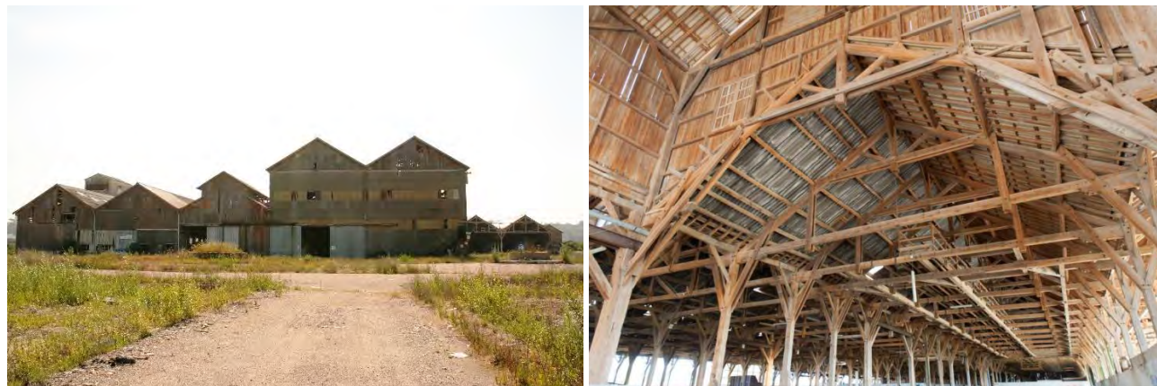
Figure 70 : Halle en bois de la Soferti (source : Ingerop, Bordeaux Métropole)
