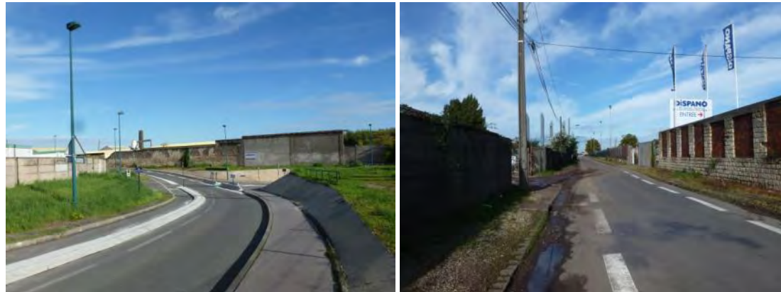
Photographie 10 : Mur d'enceinte de Point P et de Dispano
