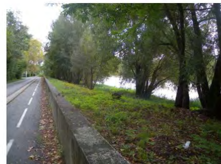
Figure 7 : Vue d'une digue en remblai soutenue côté ville (profil type 2)
