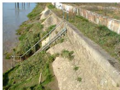
Vue d'un perré maçonné avec muret en crête présent sur le linéaire
