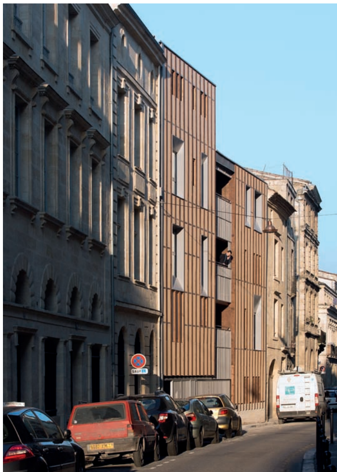
Opération Triptik, rue Carpenteyre, Bordeaux
