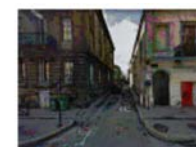
VUE RUE CHARLES DOMERGUE
