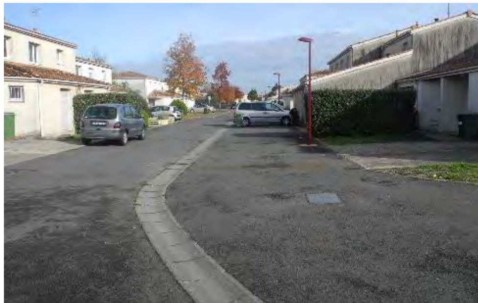
Gabarit de voirie surdimensionné
