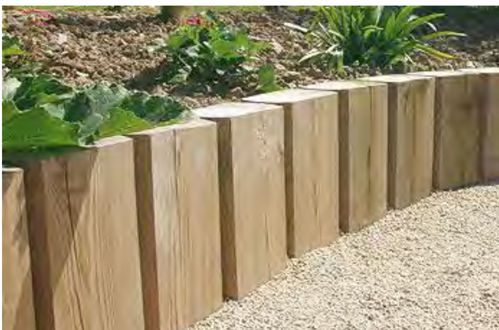
muret en traverses de bois pour dissimuler les conteneurs OM
