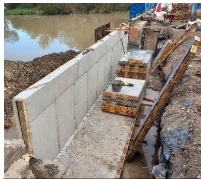
3 - Bétonnage du mur
