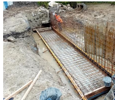
2 - Pose du ferrailage et du coffrage
