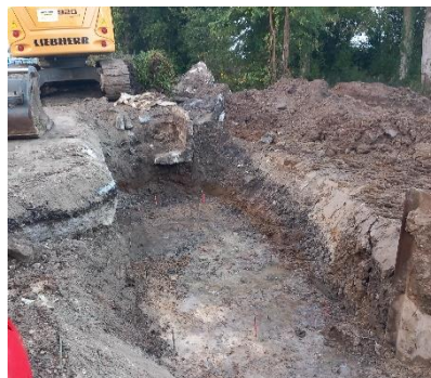
1 - Démolition et terrassement
