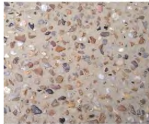
Béton désactivé pour trottoir
