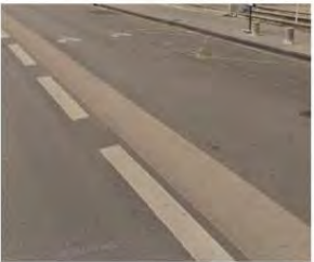
Résine ocre pour traversée cyclable en giratoire, hors réseau ReVE
