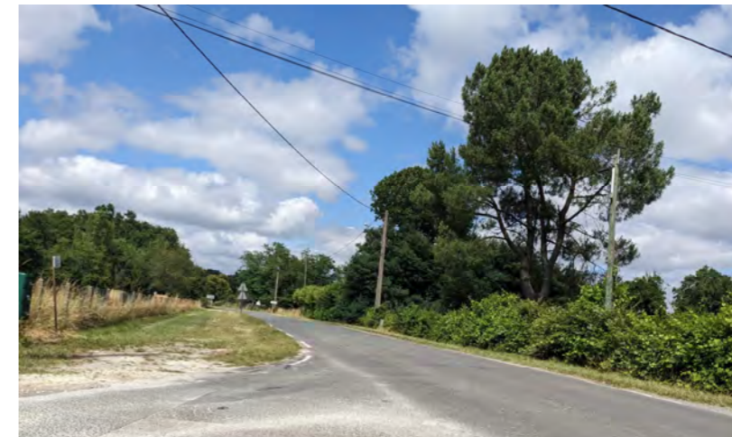
Absence d'accotement – Intersection des avenues de Touban et de Pagnot
