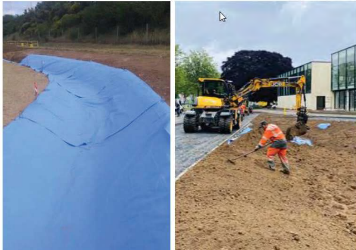
Exemple de dispositif de type aquatextile mis en place en fond de noue (à gauche) et recouvrement du dispositif par la terre végétale (à droite) - Source : Tencate-aquavia
