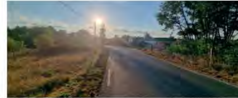
Av. de Touban, niveau déchetterie (état des lieux)
