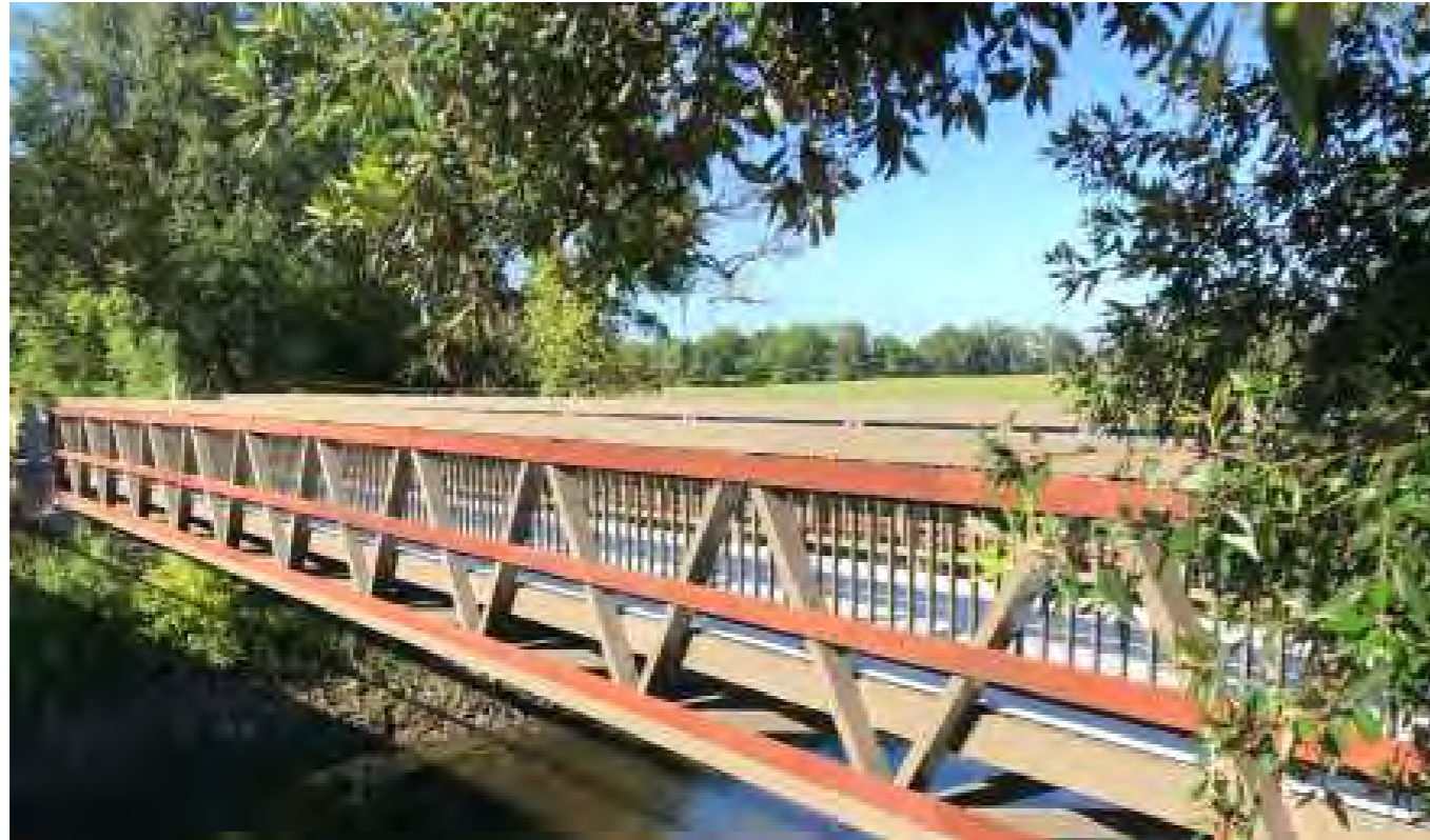
Figure 14 : Photographie – exemple de réalisation d'un ouvrage de type passerelle métalliques (Ingerop, 2024)
