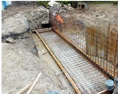
2 - Pose du ferrailage et du coffrage
