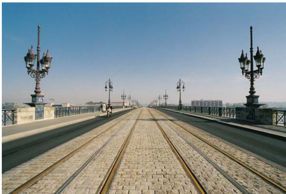
Le Pont de Pierre à Bordeaux – système d’alimentation par le sol (3ème rail central)
