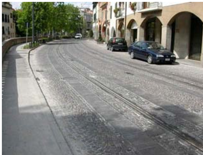
Exemple de revêtement choisi à Padoue, Italie (noter les bandes de roulement)
