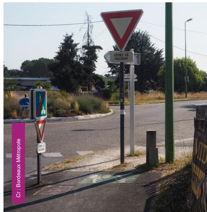
Fin de la voie verte débouchant sur un trottoir encombré avec un revêtement dégradé, non accessible pour tous.
