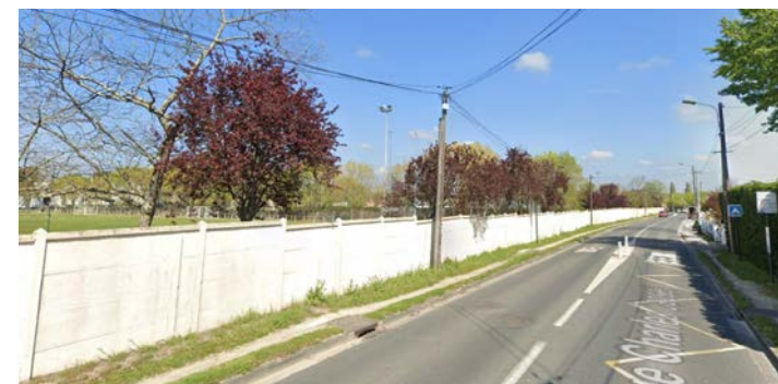
Tronçon 3 : Mur de clôture de l'équipement sportif avec plantations d'arbres en alignement ; jardins des parcelles privées en vis-à-vis
