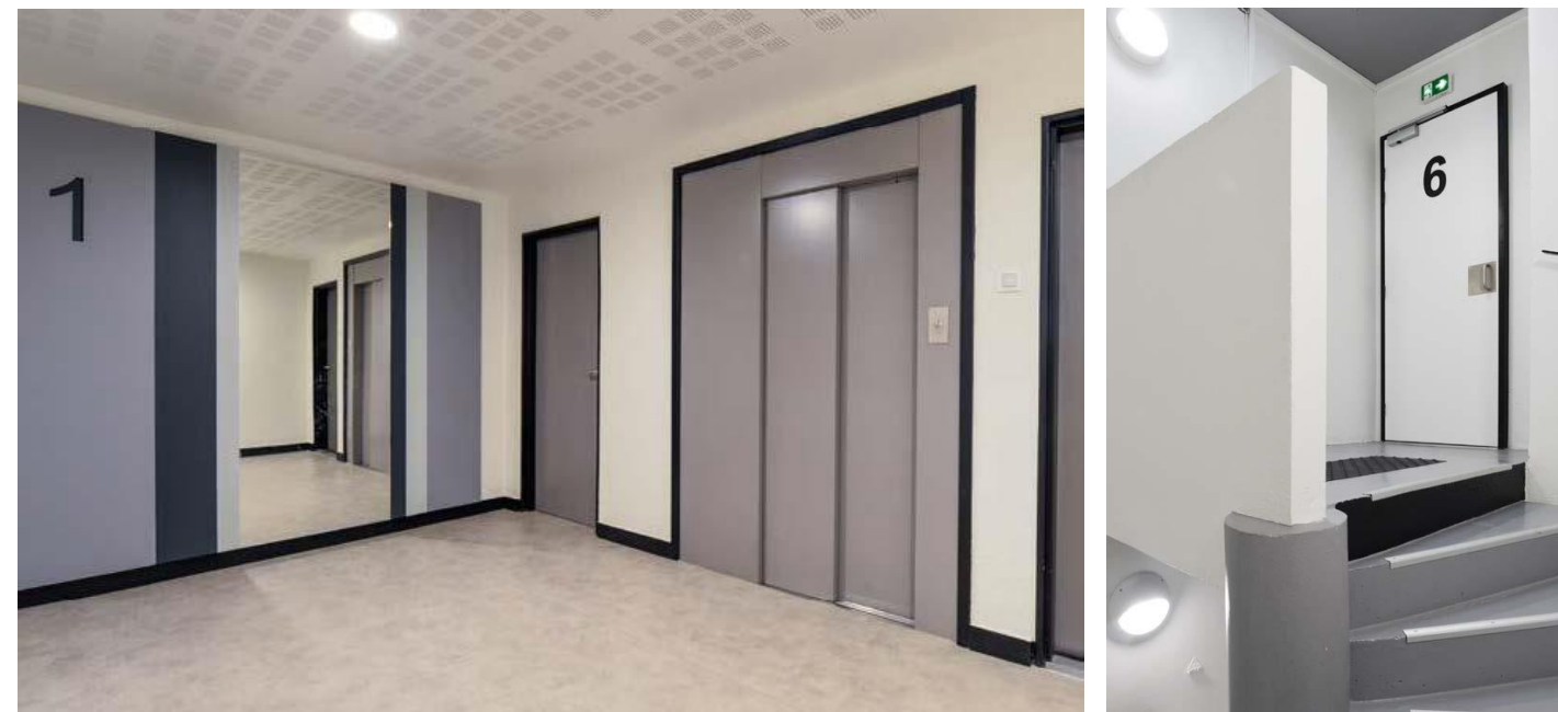
FIGURE 113. PHOTOGRAPHIES DES PARTIES COMMUNES DE BLAISE PASCAL CORNEILLE APRES LA REHABILITATION ANTICIPÉE (SOURCE : BORDEAUX METROPOLE)
