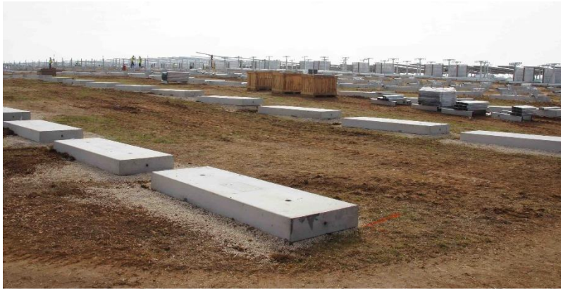
Figure 11 : Exemple de longrine en béton
