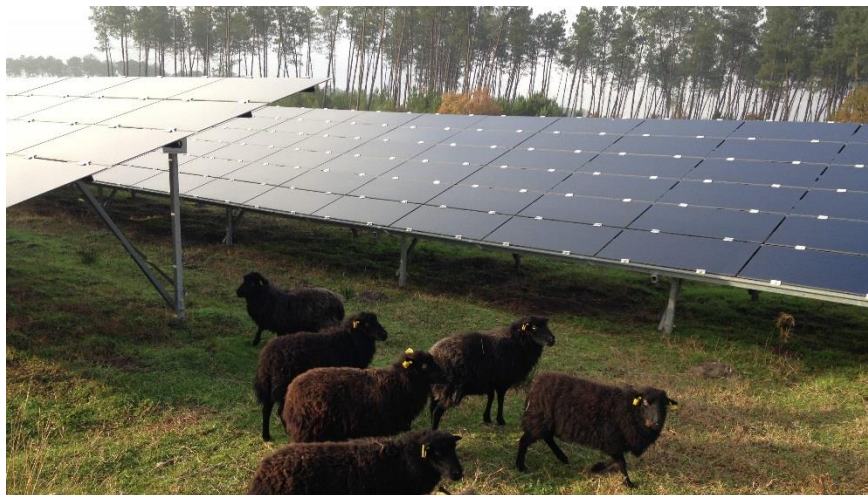
Eco-pâturage sur le parc photovoltaïque de Carcen-Ponson (Source : JPee)
